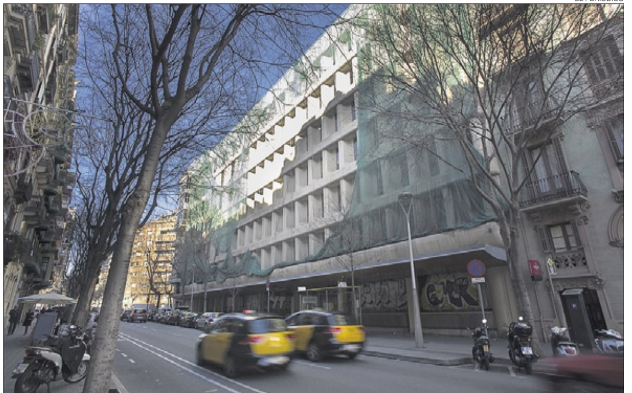
►► L'antic edifici del carrer de Calàbria que va ocupar l'ONCE, municipal i ara en desús, ahir.
